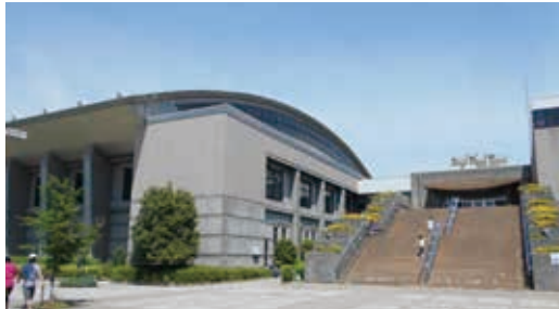
老朽化したハルシーの改修は急務
