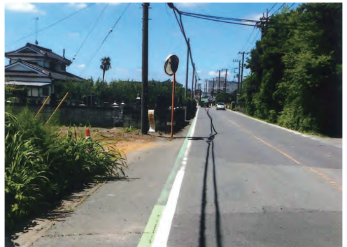
井沼交差点～浮張り団地入口区間 歩車道境界ブロックがない箇所
